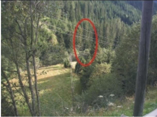
Abb. 11: Sich kreuzende Stromleitungen sind zwar selten, in der Praxis aber unvermeidbar. Ein gewisser Mindestabstand ist Pflicht laut ÖVE-Vorschrift für den Leitungsbau („L 11“) und je nach Spannung unterschiedlich.
