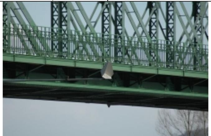
Abb. 21: „Ohne doppelten Boden“, ohne komplizierte Elektronik, einfach drei Blechplatten. Dasselbe Prinzip wird bei Fahrradreflektoren – allerdings nicht in Blech sondern in Kunststoff - angewendet.
