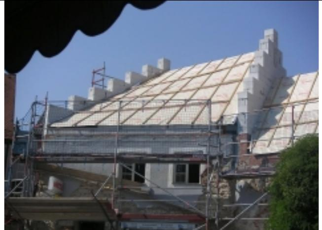
Abb. 12: „Windschiefes Dach“ (HP-Flächenstück, fotografiert in Kipfenberg an der Altmühl / D): Benachbarte Sparren sind zueinander windschief, ebenso wie die beiden Ortgänge. Die Dachlatten sind alle verschieden lang
