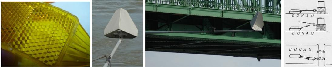
Die Parallelreflexion an Würfecken hat praktische Bedeutung: Reflektor beim Fahrrad, Radarreflektor bei Donaubrückenpfeilern. Ohne diese Parallelreflexion wären die Brückenpfeiler am Radarschirm nicht sichtbar.
